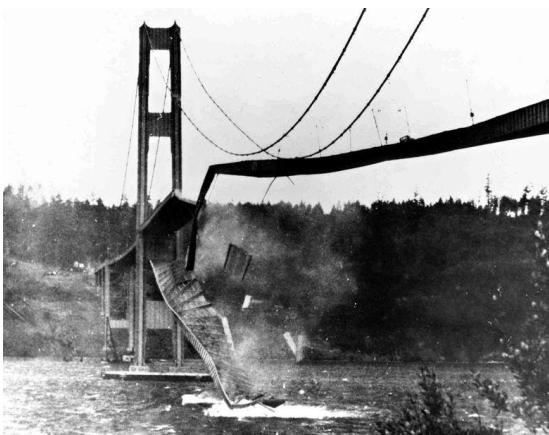
Figuur 29: De instorting van de Tacoma Narrows Bridge
