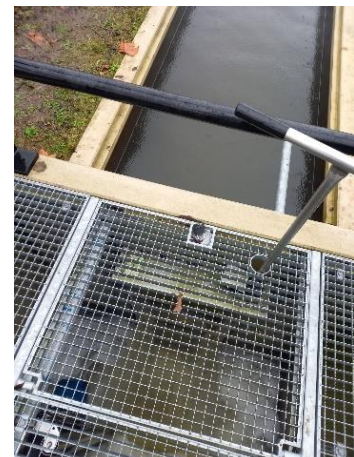
Figuur 13: Handmatig verstelbare sluis
